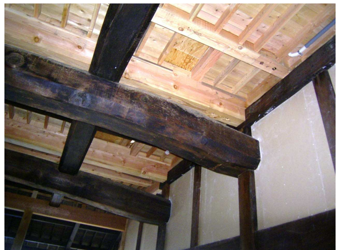
6. 工事中の内観
