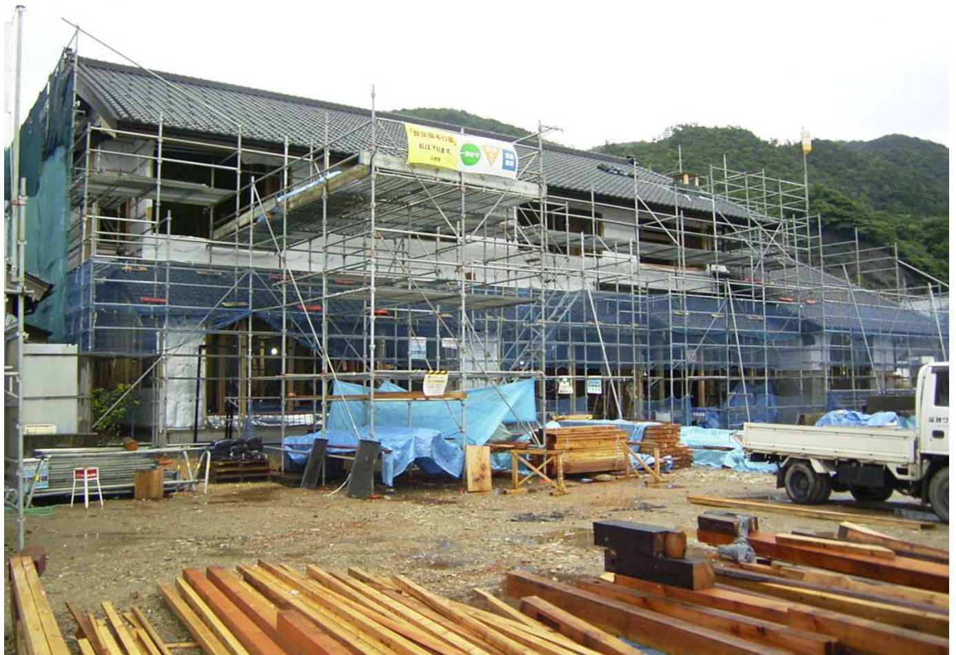
4. 工事中の外観
